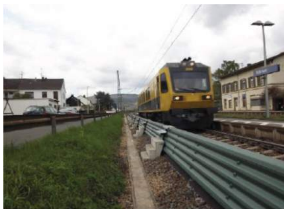
Rys. 40 Niski ekran przeciwhałasowy (wysokość 0.75 m) [DB Netze: Innovative Maßnahmen zum Lärm- und Erschütterungsschutz am Fahrweg , Schlussbericht, 15.06 2012]
