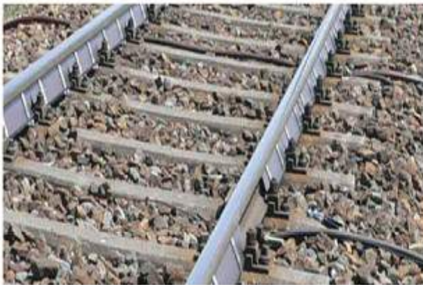
Rys. 38 Osłony szyn (DB Netze: Innovative Maßnahmen zum Lärm- und Erschütterungsschutz am Fahrweg , Schlussbericht, 15.06 2012)
