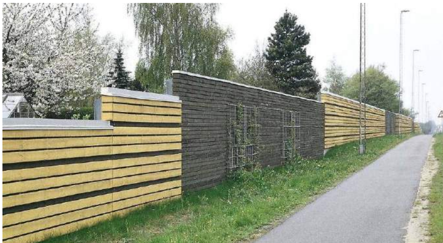
Rys. 29 Ekran przeciwhałasowy (drewniany) [Źródło: POŚPH 2013]
