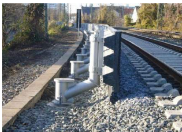
Rys. 41 Niski ekran przeciwhałasowy, nieodchylany [DB Netze: Innovative Maßnahmen zum Lärm- und Erschütterungsschutz am Fahrweg , Schlussbericht, 15.06 2012]
