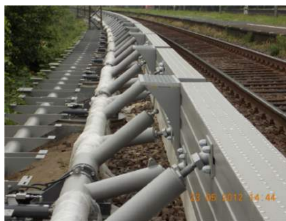
Rys. 42 Niski ekran przeciwhałasowy, odchylany [DB Netze: Innovative Maßnahmen zum Lärm- und Erschütterungsschutz am Fahrweg , Schlussbericht, 15.06 2012]
