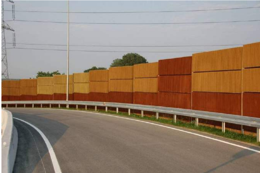
Rys. 28 Ekran przeciwhałasowy (betonowy) [Źródło: POŚPH 2013]
