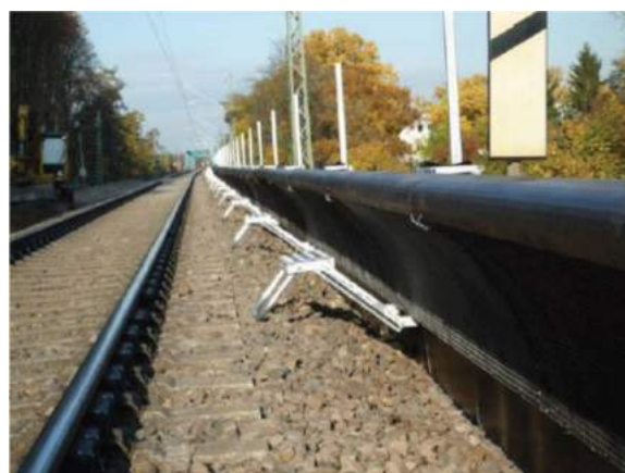
Rys. 41 Niski ekran przeciwhałasowy, nieodchylany [DB Netze: Innovative Maßnahmen zum Lärm- und Erschütterungsschutz am Fahrweg , Schlussbericht, 15.06 2012]
