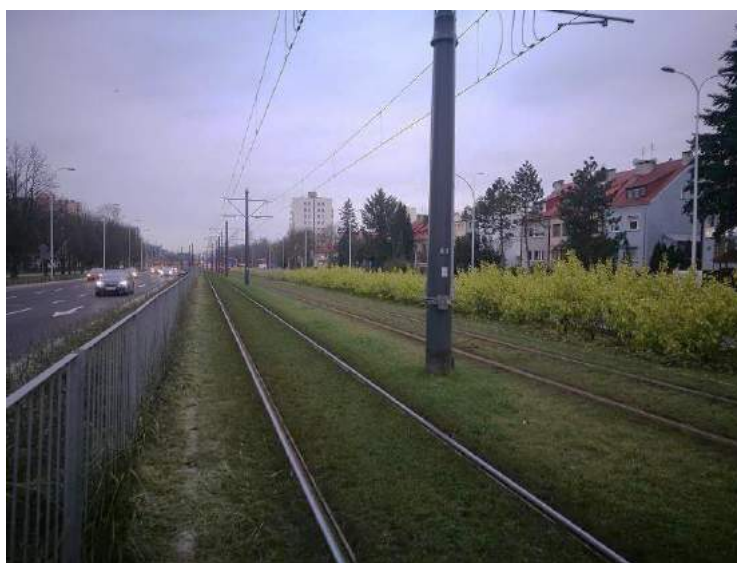
Rys. 46 Wykonana przez ZMID przebudowa torowiska tramwajowego w ciągu ul. Wołoskiej wraz z wykonaniem nasadzeń zieleni – Zadanie HT8 z Programu 2013 [Zdjęcie Mariusz Truskowski]
