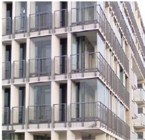
Rys. 13 Budynek z balkonami, na których zamocowano „szklane ekrany akustyczne” – Plac Grunwaldzki w Warszawie [Zdjęcie Radosław Kucharski]
