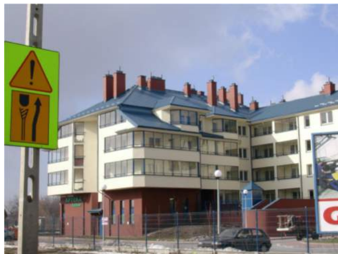
Rys. 14 Zabezpieczenie przed hałasem za pomocą przeszklonego korytarza – ul. Łodygowa w Warszawie [Zdjęcie Radosław Kucharski]
