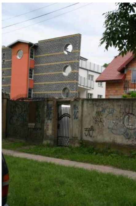
Rys. 15 Indywidualna ochrona budynku przed hałasem kolejowym. Ekran elewacyjny – Warszawa – Włochy [Zdjęcie Radosław Kucharski]
