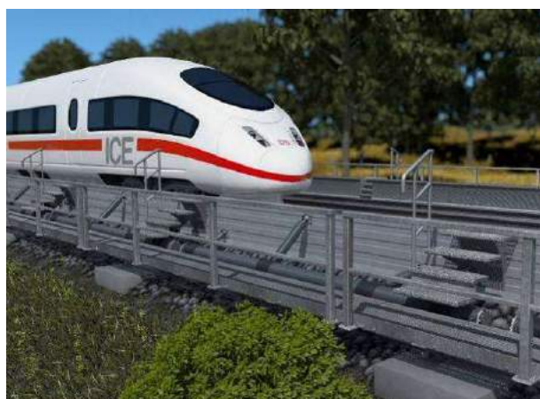
Rys. 42 Niski ekran przeciwhałasowy, odchylany [DB Netze: Innovative Maßnahmen zum Lärm- und Erschütterungsschutz am Fahrweg , Schlussbericht, 15.06 2012]
