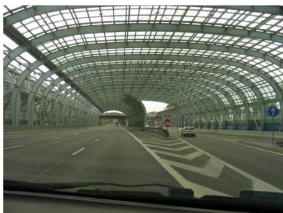
Rys. 32 Ekran przeciwhałasowy typu półtunel chroniący zabudowę wysoką – Trasa S8 w Warszawie [Zdjęcia Radosław Kucharski]
