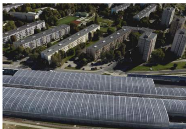
Rys. 32 Ekran przeciwhałasowy typu półtunel chroniący zabudowę wysoką – Trasa S8 w Warszawie [Zdjęcia Radosław Kucharski]
