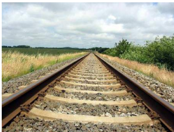
Rys. 35 Torowisko kolejowe. Szyny bezstykowe, mocowanie szyn do podkładów kolejowych z wykorzystaniem sprężystych podkładek [Źródło: POŚPH 2013]
