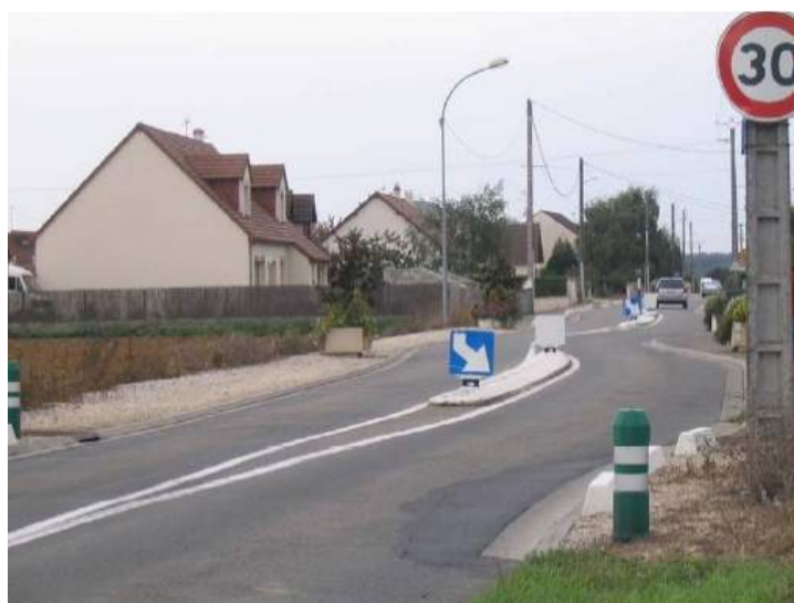
Rys. 22 Przewężenie na drodze – ograniczenie prędkości ruchu [Źródło j.w.]
