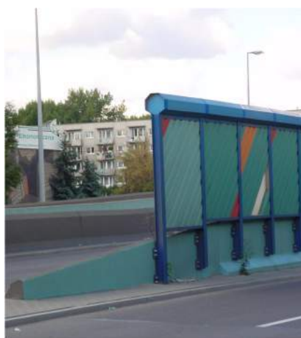
Rys. 33 Ekran przeciwhałasowy z dyfraktorem – ul. Prymasa Tysiąclecia w Warszawie [Zdjęcie Radosław Kucharski]
