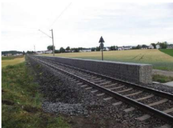
Rys. 40 Niski ekran przeciwhałasowy (wysokość 0.75 m) [DB Netze: Innovative Maßnahmen zum Lärm- und Erschütterungsschutz am Fahrweg , Schlussbericht, 15.06 2012]
