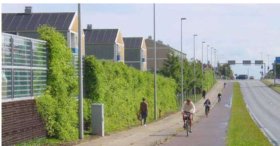
Rys. 30 Ekran przeciwhałasowy (przezroczysty, porośnięty roślinnością) [Źródło: POŚPH 2013]
