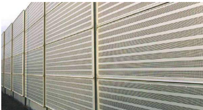
Rys. 31 Ekran przeciwhałasowy (dźwiękochłonny) [Źródło: POŚPH 2013]
