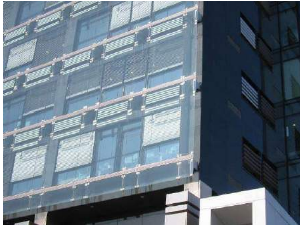
Rys. 12 Budynek biurowy z tzw. „szklanymi ekranami na elewacji” - Trasa Łazienkowska w Warszawie [Zdjęcie Radosław Kucharski]
