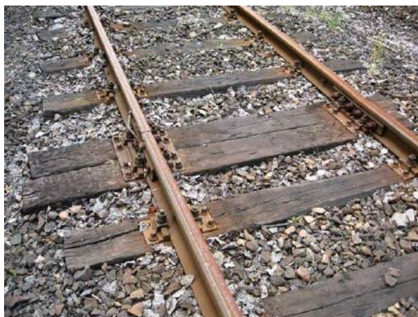
Rys. 34 Torowisko kolejowe. Szyny stykowe, mocowanie szyn do podkładów „na sztywno” [Źródło: POŚPH 2013]
