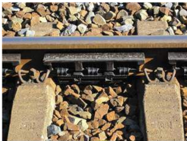
Rys. 39 Tłumiki drgań [DB Netze: Innovative Maßnahmen zum Lärm- und Erschütterungsschutz am Fahrweg , Schlussbericht, 15.06 2012]
